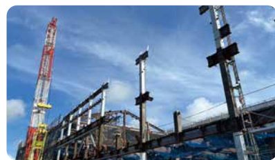
建設中の（仮称）みどりが丘小学校分離新設校
